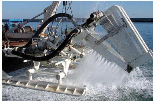
Exemple de water jetting
