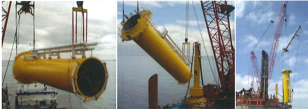
Figure 4 : Mise à l'eau de la pièce de transition (source DONG Energy).
