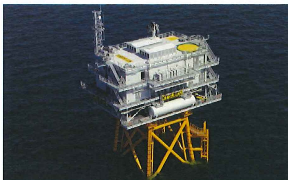
Figure 2 : Poste électrique en mer du parc éolien de Walney (DONG Energy)
