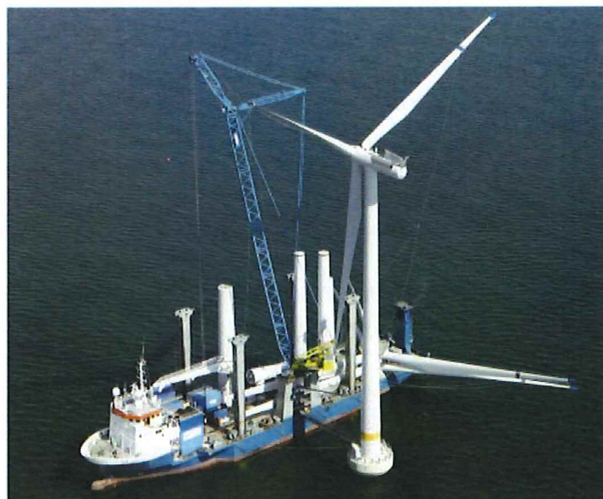
Figure 5 : Navire d'installation après montage d'un aérogénérateur (source A2SEA).
