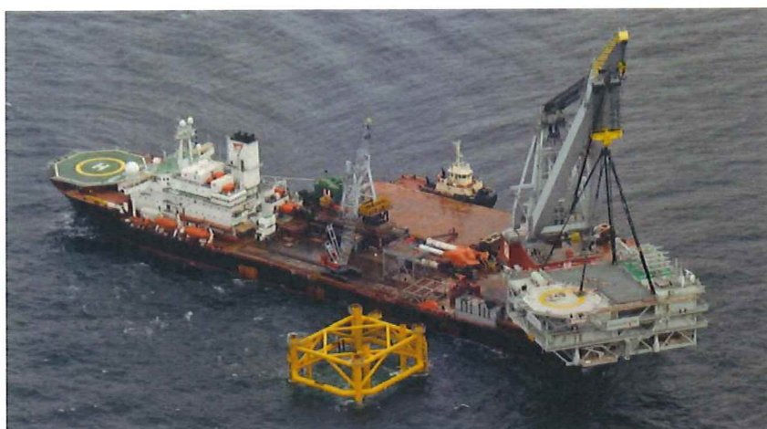
Figure 7 : Installation d'une sous-station (source DONG Energy).
